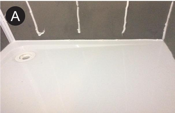
Entlang des Tassenrandes eine Raupe EASY SEAL XS (Universelle Polymer-Dichtmasse) ziehen, damit die Platten am Boden versiegelt sind.
