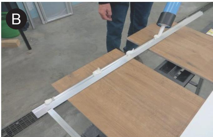
Den POWERBOND XS 330 (Power Montagekleber) im Abstand von 20 cm punktuell auf das Eckprofil auftragen.
