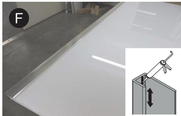
Im Abschlussprofil eine durchgehende Raupe EASY SEAL XS ziehen und für 10 Minuten bis zum Anschlag in die Platte drücken.
