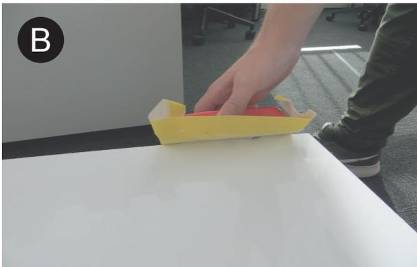
Die Kanten der Platte nach dem Schneiden mit Schleifpapier bearbeiten.
