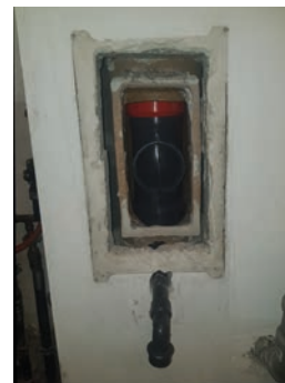
Abb. 19: Kontroll-Rohr eingebaut
