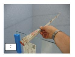
8. Abtrennungstiefe -20 mm = Halterohrlänge. Ermittelte Länge auf das Halterohr übertragen.
