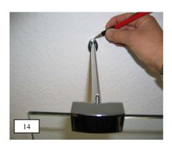
15. Gelenkkopf wieder von der Gelenkplatte lösen. Lochdurchmesser 8 mm an markierter Position bohren. Dübel setzen und Stockschraube M6 x 60 bis auf eine Restlänge von 6 - 8mm eindrehen. Anschließend die Gelenkplatte aufschrauben und senkrecht ausrichten.
