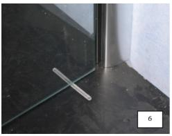
Je nach Bedarf Verglasungsklötze in 2 oder 3 mm Stärke vor das Wandprofil auf den Wannenrand oder Fliesenboden legen. Kantenschutz unten und profilseitig von der Scheibe entfernen. Scheibe vorsichtig darauf absetzen, in den Aufnahmespalt zwischen den Profilen einschieben und Klemmschrauben anziehen.
