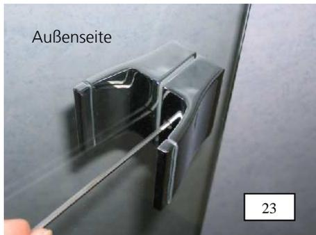
23. Die Zweite Griffhälfte gemeinsam mit der Griffunterlage von außen über die Befestigungshülse schieben und durch Eindrehen des Gewindestiftes M5 auf der Befestigungshülse fixieren. Gewindestift hierbei fest anziehen.
