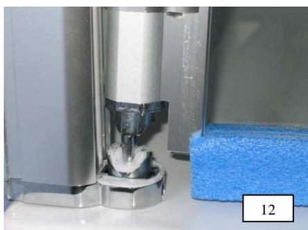
12. Flügel Anschlagseite auf den Drehzapfen der unteren Gelenkplatte aufsetzen. Auf die Bezeichnung der Flügel achten (oben außen links).
