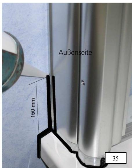
35. Versiegelung an der Gelenkeinheit von außen ca. 150 mm senkrecht in der Höhe und waagrecht an der Gelenkplatte bis zur vorderen Öffnung, diese komplett versiegeln.
