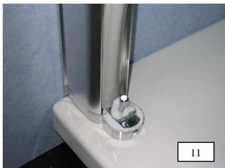
11. Die Gelenkdichtung unten auf die Gelenkplatte aufsetzen, anschließend auf der ganzen Länge vorsichtig in den Pfosten eindrücken.
