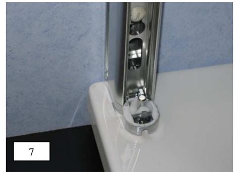
8. Gelenkeinheit lotrecht ausrichten und mit Spaxschrauben 4,5 x 45 mm befestigen. Anschließend muss das Gelenkprofil mit den weißen Kunststoffschrauben lotrecht ausgerichtet werden.
