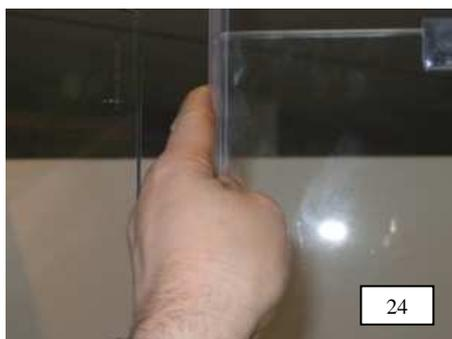
24. Spaltdichtung oben einige Zentimeter am anschlagseitigen Türflügel aufstecken, somit wird ein Abknicken verhindert. Die Ausklinkung muss unten sein. Die Dichtlippe sollte sich innen befinden und am schließseitigen Flügel anliegen. Der Abstand zwischen Unterkante der Dichtung und der Duschkante darf max. 1 mm betragen. Anschließend mit der Scheibenoberkante bündig zuschneiden.
