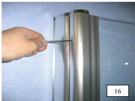
16. Flügel Anschlagseite lotrecht ausrichten. Hierzu wird der Flügel nach innen gefaltet, die Bohrungen der Justierschrauben werden sichtbar. Mit Innensechskant SW 4 Einstellung vornehmen.
