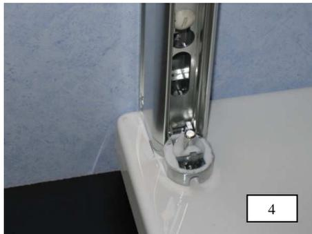
4. Gelenkeinheit an die Markierung setzen.
