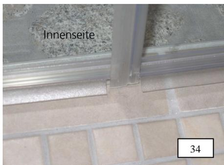
34. Die Darstellung zeigt von innen den kompletten Zusammenbau der Dichtungen zwischen den beiden Türflügeln. Nun kann mit der Versiegelung begonnen werden.
