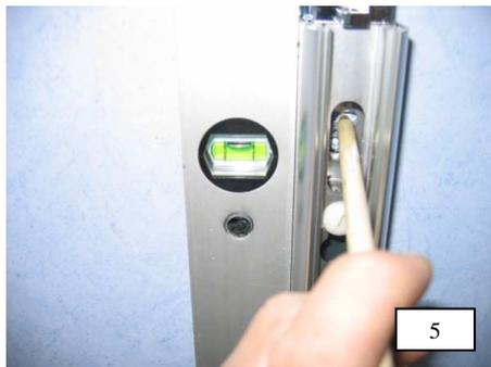
5. Gelenkeinheit lotrecht ausrichten, Bohrungen anzeichnen, bohren und Dübel setzen.
