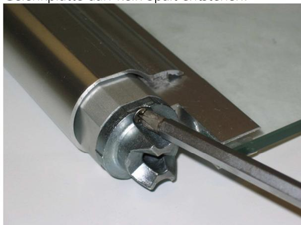
6) neue Drehplatte am Türflügel unten montieren
