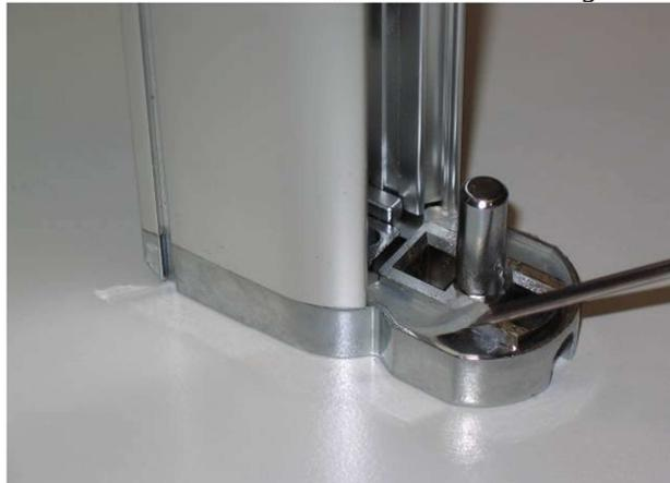
3) Gelenkplatte unten reinigen und Silikonreste komplett entfernen.
