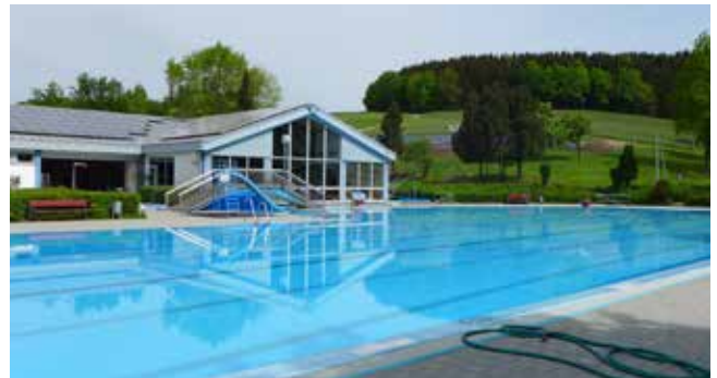
Dachmontage Freibad Gramming
