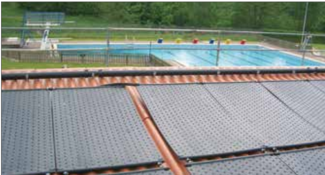
Dachmontage Freibad Knüllwald-Remsfeld
