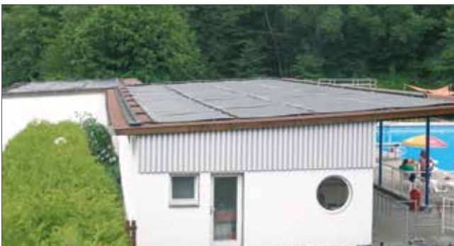
Dachmontage Freibad Holzhausen
