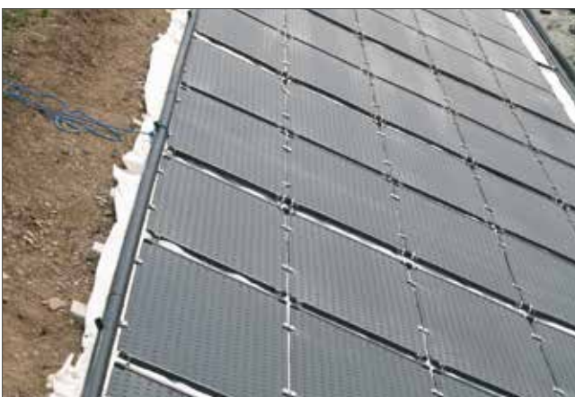
Montage auf schräger Freifläche
