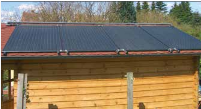
Dachmontage Kleinanlage Nordhorn
