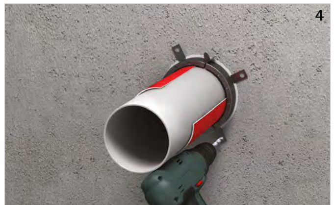
Ggf. anzeichnen und erstellen der Befestigungspunkte (optional dürfen die Laschen auch 90° umgebogen und eingemörtelt werden).
