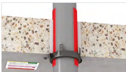
Halteflaschen einge- mörtelt (90° umgebogen)
