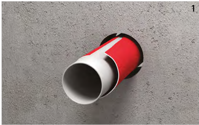
Rohrleitung (ggf. mit PE-Schallschutzschlauch) durchführen.
