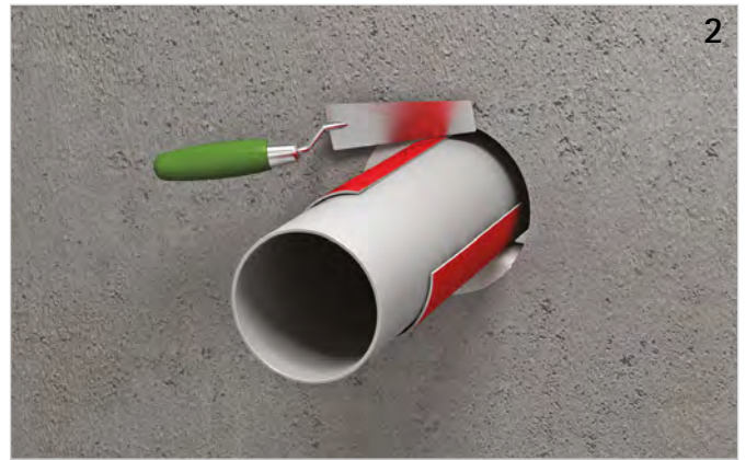
Restspalt rauchgasdicht (mit z. B. Walraven Pacifyre® FPM Brandschutzmörtel) verschließen.
