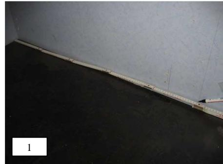
2. Je nach Bedarf Verglasungsklötze in 2 oder 3 mm Stärke an die Position der Scheibe auf den Wannenrand oder Fliesenboden legen. Kantenschutz unten und wandseitig von der Scheibe entfernen. Scheibe vorsichtig darauf absetzen.
