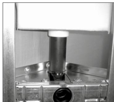
3) Element an der Wand ausrichten, Dübellöcher anzeichnen, bohren und mit beiliegenden Befestigungsätzen verdübeln.
