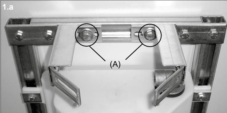
1) Die oberen Wandwinkel demontieren (A) und das Knotenblech an den frei werdenden Montageplatten befestigen (B).
