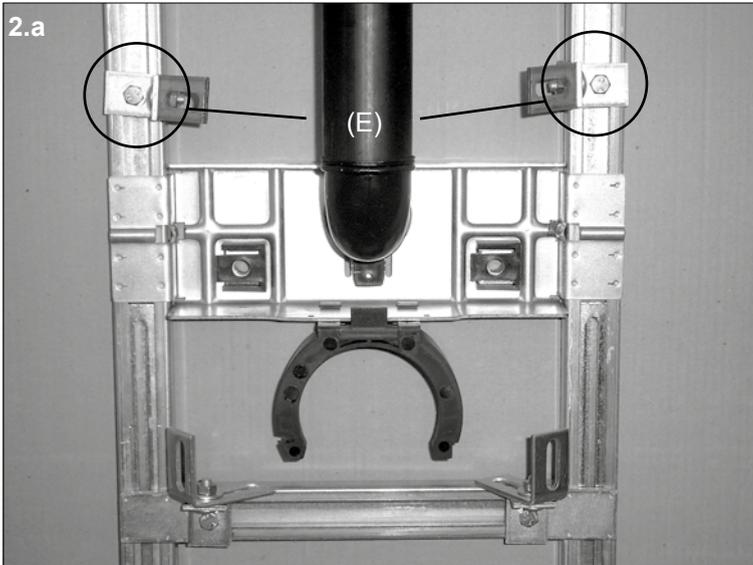
2) Die mittleren Befestigungswinkel (E) entfernen und das untere Knotenblech an den inneren Befestigungspunkten mit den beiliegenden Schrauben an der WC-Bolzenschiene verschrauben (F).
