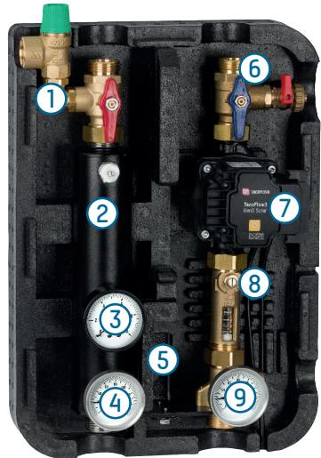
**1 Absperr-Kugelhahn mit Sicherheitsventil und integriertem Rückflussverhinderer**
